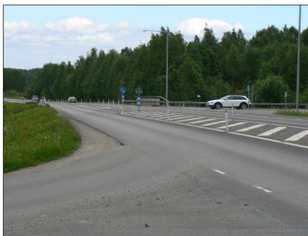
Fig 43 Korsning väg 506/Lillåkersvägen.
