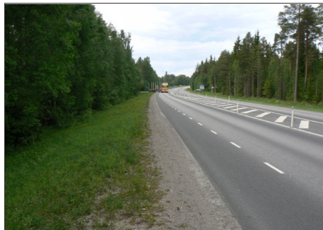
Fig 40 Vy mot befintlig korsning väg 506/Viaduktsvägen.
